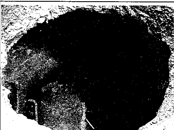
Fotografía 12. Detalle del sistema de alcantarillado para recolección de agua de lluvia, ubicado en la Carrera 16 Este, entre las manzanas 1 y 2 del desarrollo Triángulo Alto. El sistema se encuentra colmatado de material, y en el momento de la visita se observó sin agua.
