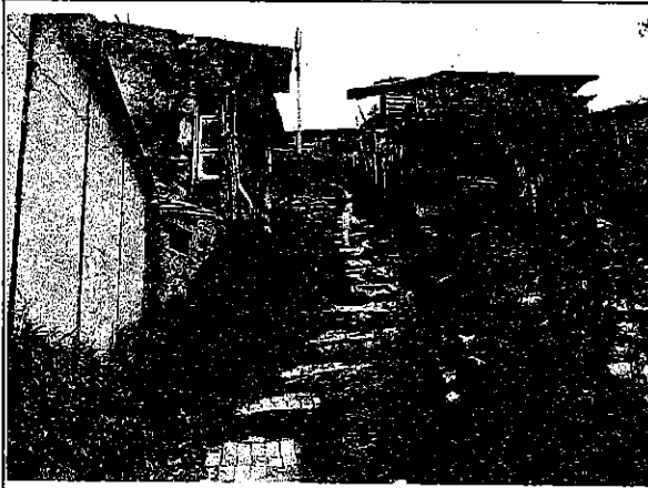
Fotografía 14. Senderos peatonales por los cuales corren las aguas lluvias, ya que las viviendas no cuentan con sistemas de captación, conducción y vertimiento de esas aguas.
